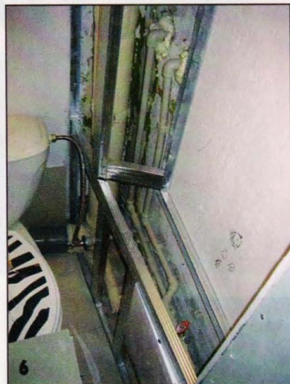
Старые трубы заменил на новые — пластиковые.
