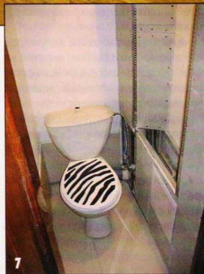
Каркас из металлических профилей обшил гипсокартоном.
