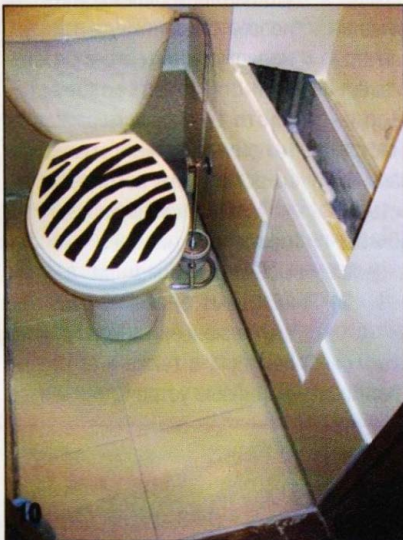
Облицовку керамогранитом выполнил по низу стены и по гипсокартонной обшивке, после чего установил унитаз окончательно на своё место.
