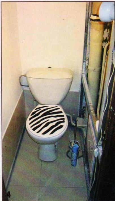
Керамогранит уложил на пол и облицевал им нижнюю часть стен.
