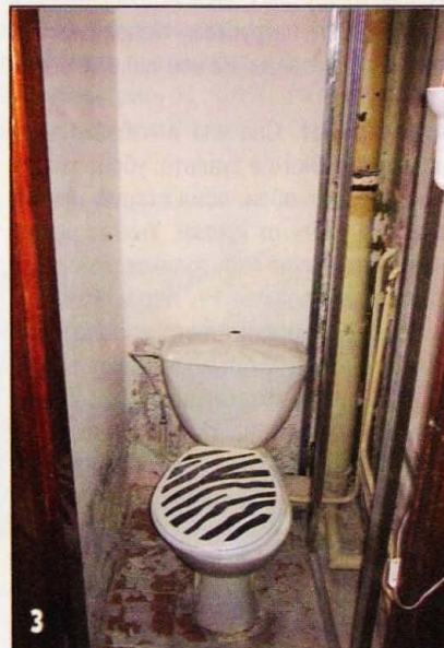
Зашпатлевав большую часть поверхности стен, приступил к монтажу каркаса под обшивку ГКЛ.
